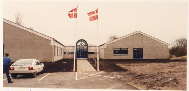
DEN 3 MARTS ER ESK 726 NY BYGNING ENDELIG KLAR TIL OVERTAGELSE OG INDFLYTNING.
