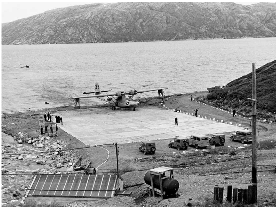
Platform til Catalina på Grønnedal. På havbunden udfor er der lagt stålmåtter
