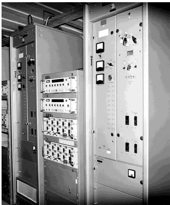
Marconi H-1000, der i mange år har været det bærende HF senderudstyr i Flyvevåbnet
