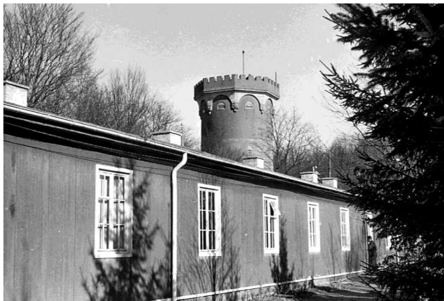
Den første Fenrikskole i bygning 67 på Flyvestation Værløse.
