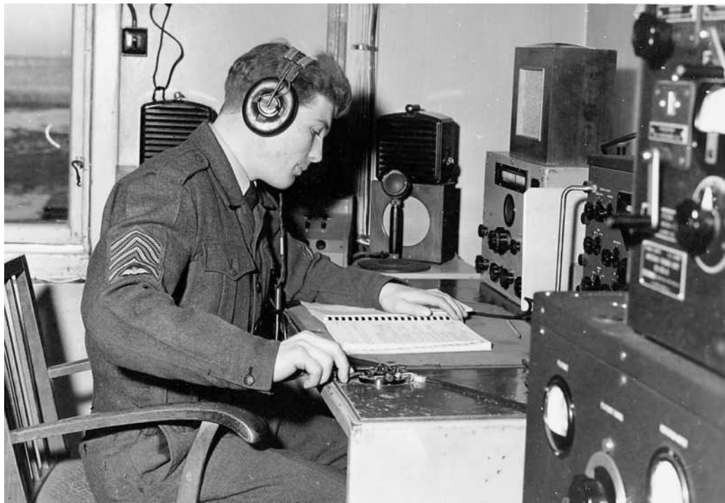
Oversergent P. Christensen på Flyvestation Tirstrup radiostation, 1958. I forgrunden BC-610 transmitter. Udstyret i baggrunden er dubleret fra flyvekontrollen, så radiooperatør havde medhør og også kunne afløse i den funktion.
