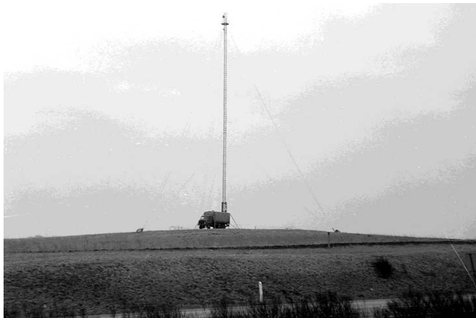
Lehmann mast opstillet på Antvorskov kaserne.
